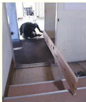
引き戸レールの 凹凸を計測
