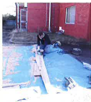
スロープの傾斜に 合わせて板木を切断
